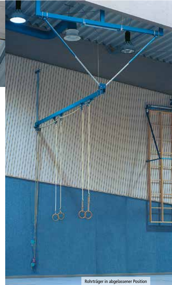
Rohrträger in abgelassener Position
